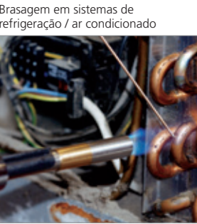
Alta temperatura da chama com base no redemoinho do ciclone
