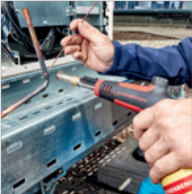
Brasagem em sistemas de refrigeração / ar condicionado
