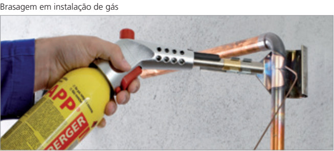
Brasagem em instalação de gás
