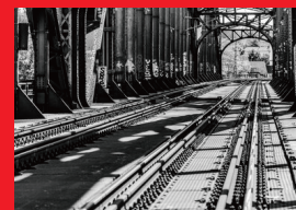
Construção de estradas e pontes
